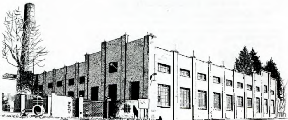
■ Zabytkowa stacja wodociągowa „Zawada” w Karchowicach
